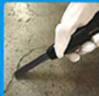
コンクリートの目張りはがし
