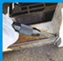
溶接スラグ落とし
